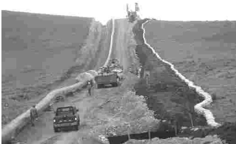
► El gasoducto atravesará nueve distritos en dos provincias de la región de Ayacucho.
