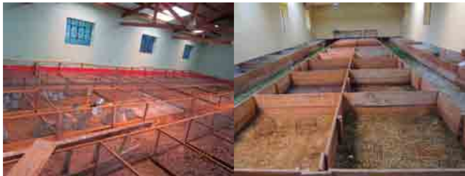
Proyecto: "Construcción del Galpón de Cuyes" en las comunidades de Pueblo Libre y Huaylacucho, Huancavelica. Visitado en abril de 2013.
